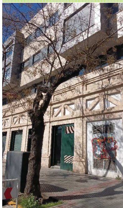
Vista detalle de la copa formada por brotaciones epicórmicas.
