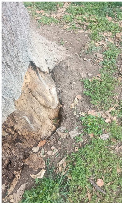
Detalle de la degradación en cuello
