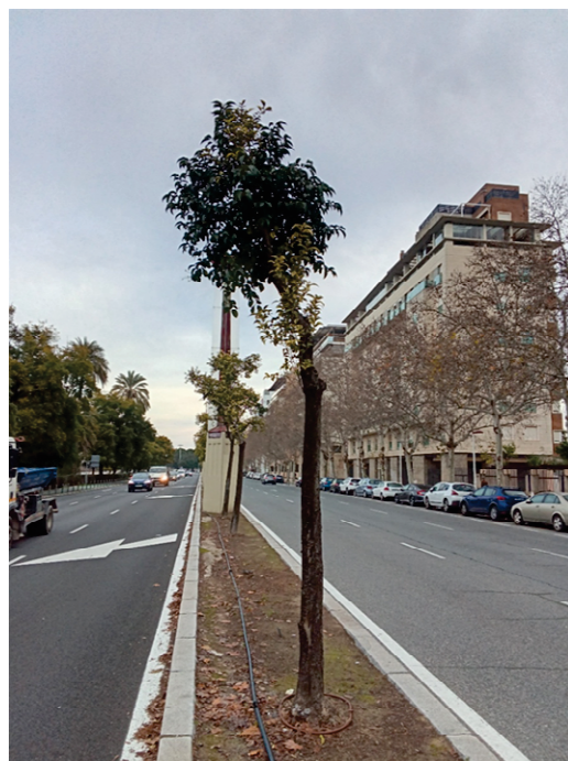
Vista general: ligeramente inclinado en alcorque corrido de mediana con interferencia con vehículos.
