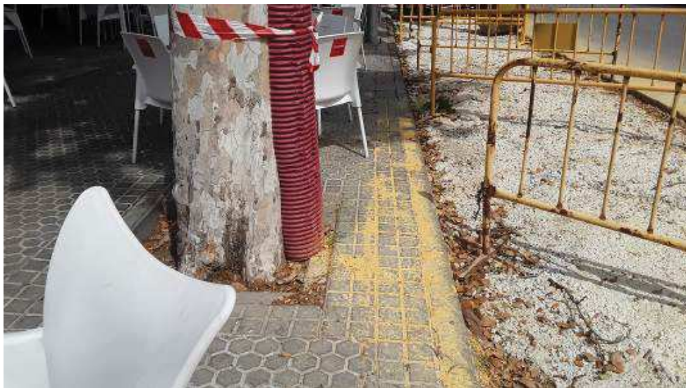
Vista obra 2021 (Ficha de Inspección 2021)
