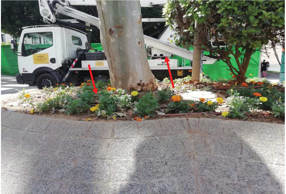
13. Vista de la base. Detalle abultamiento en tensión y ligero hundimiento en compresión
