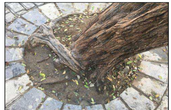
9. Inspección 2019. Detalle de la base
