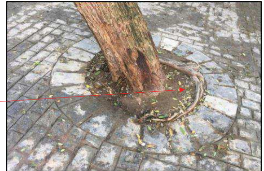
7. Inspección 2019. Detalle de la base
