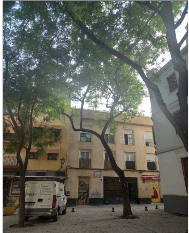
4. Vista general. Ahilamiento
