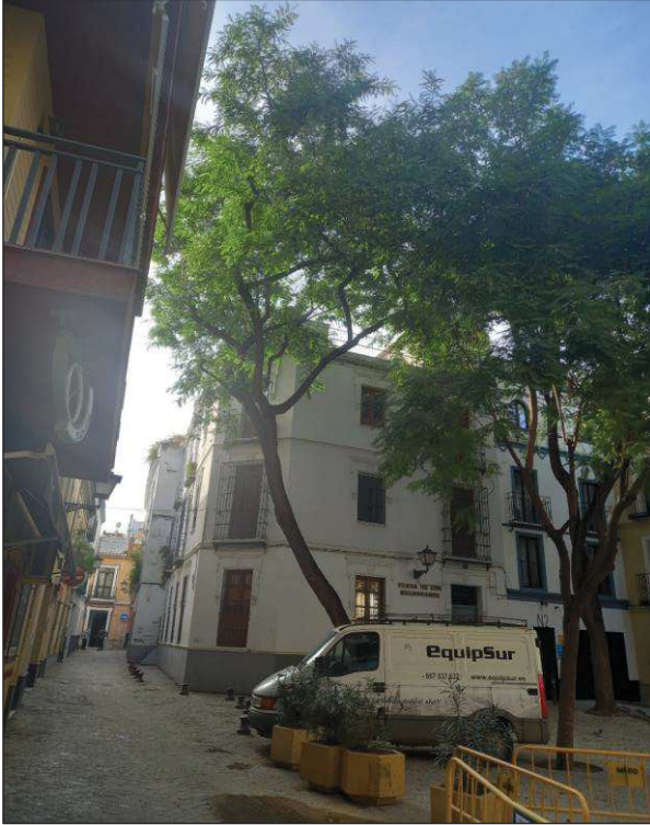
1. Vista general de la posición
