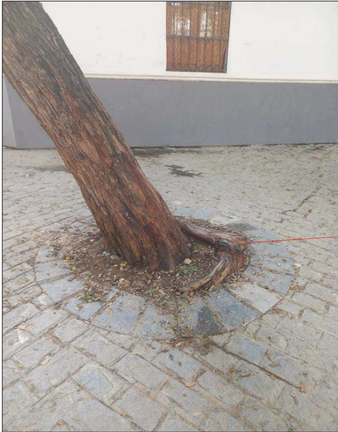
6. Vista actual de la base. Raíces superficiales dañadas
