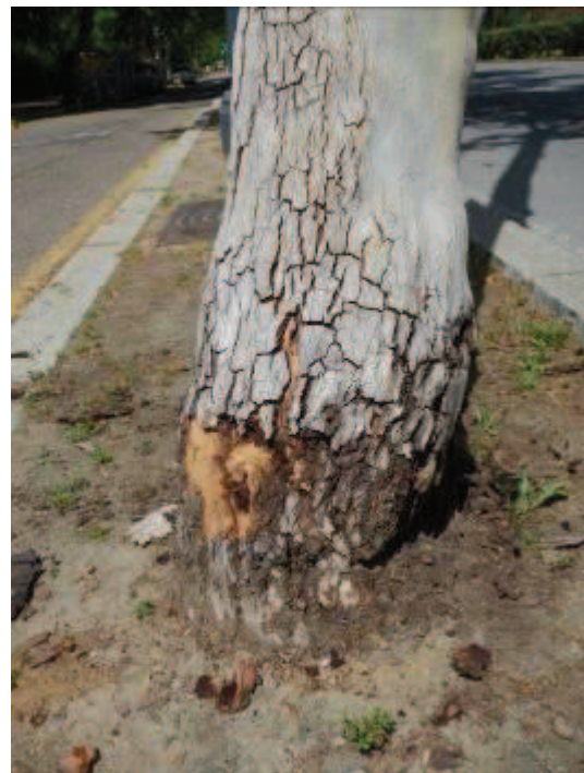
Detalle del chancro en la zona de tracción
