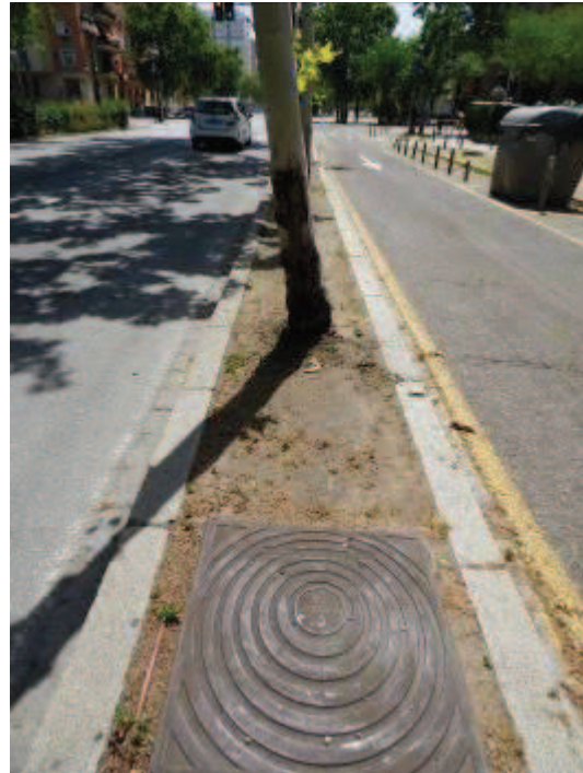
Vista de interferencias próximas a la posición (farola y arqueta de servicios subterráneos de alumbrado público)
