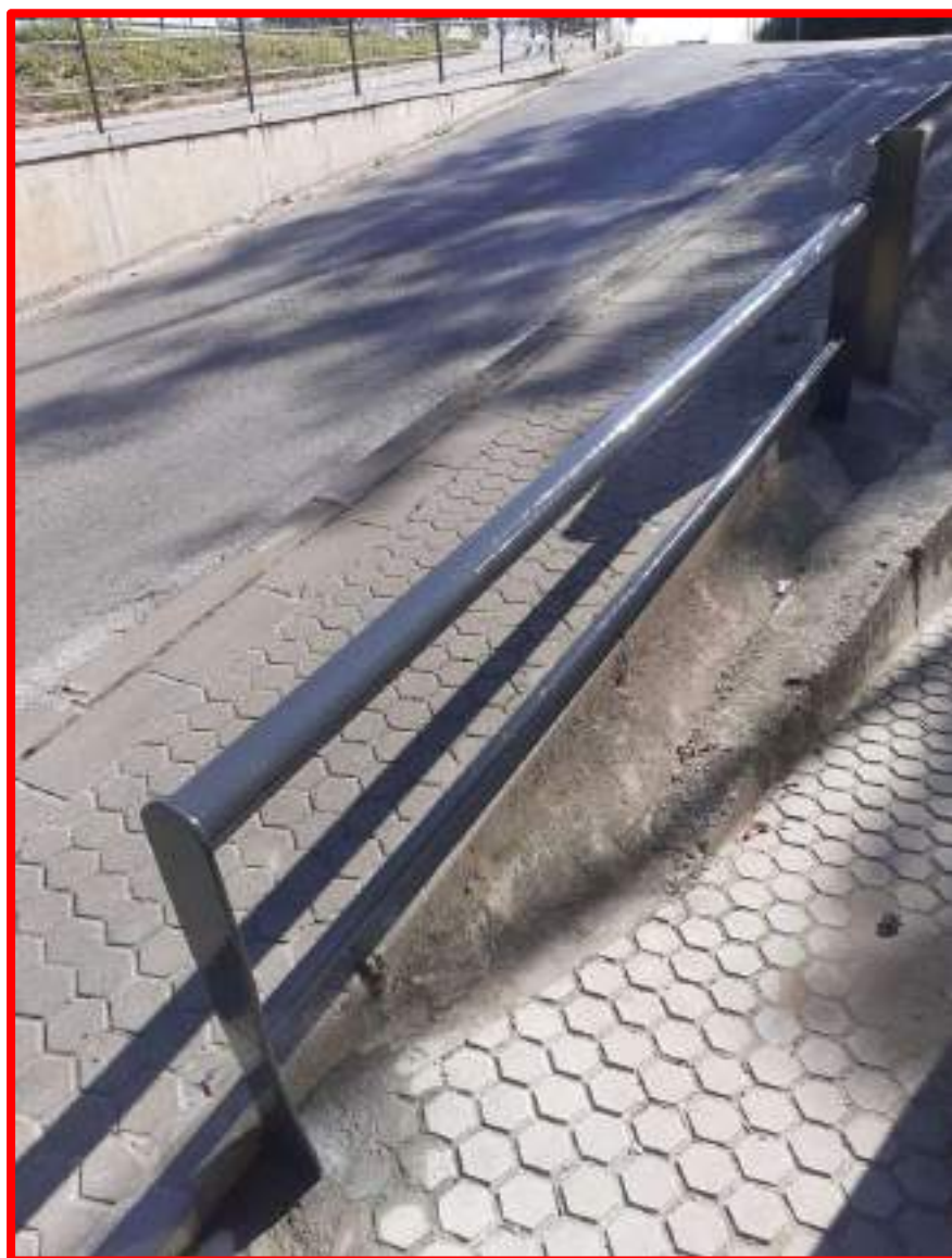
Instalación barandilla acceso peatonal Ronda de Padre Pío
