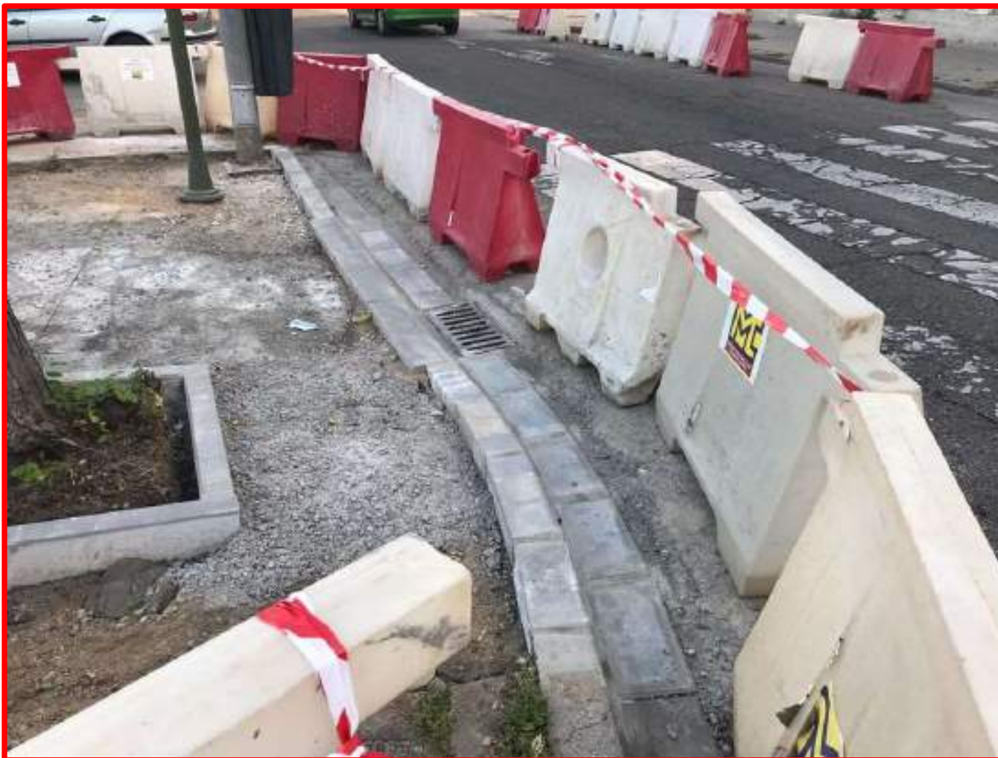
Reparación acerado y alcorques C/ Galaxia
