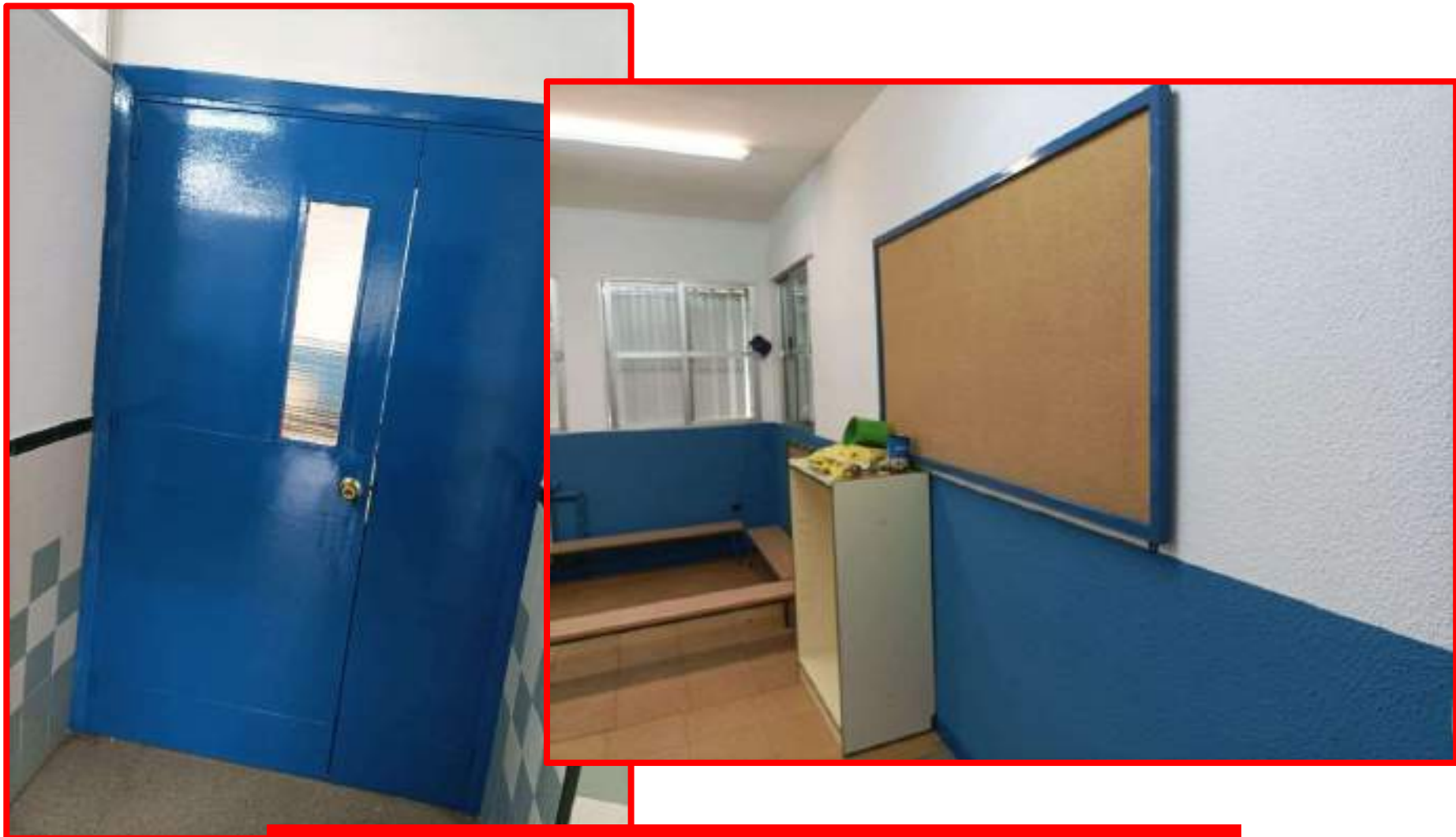
Pintado interior aulas infantil y primaria C.E.I.P. Emilio Prados
