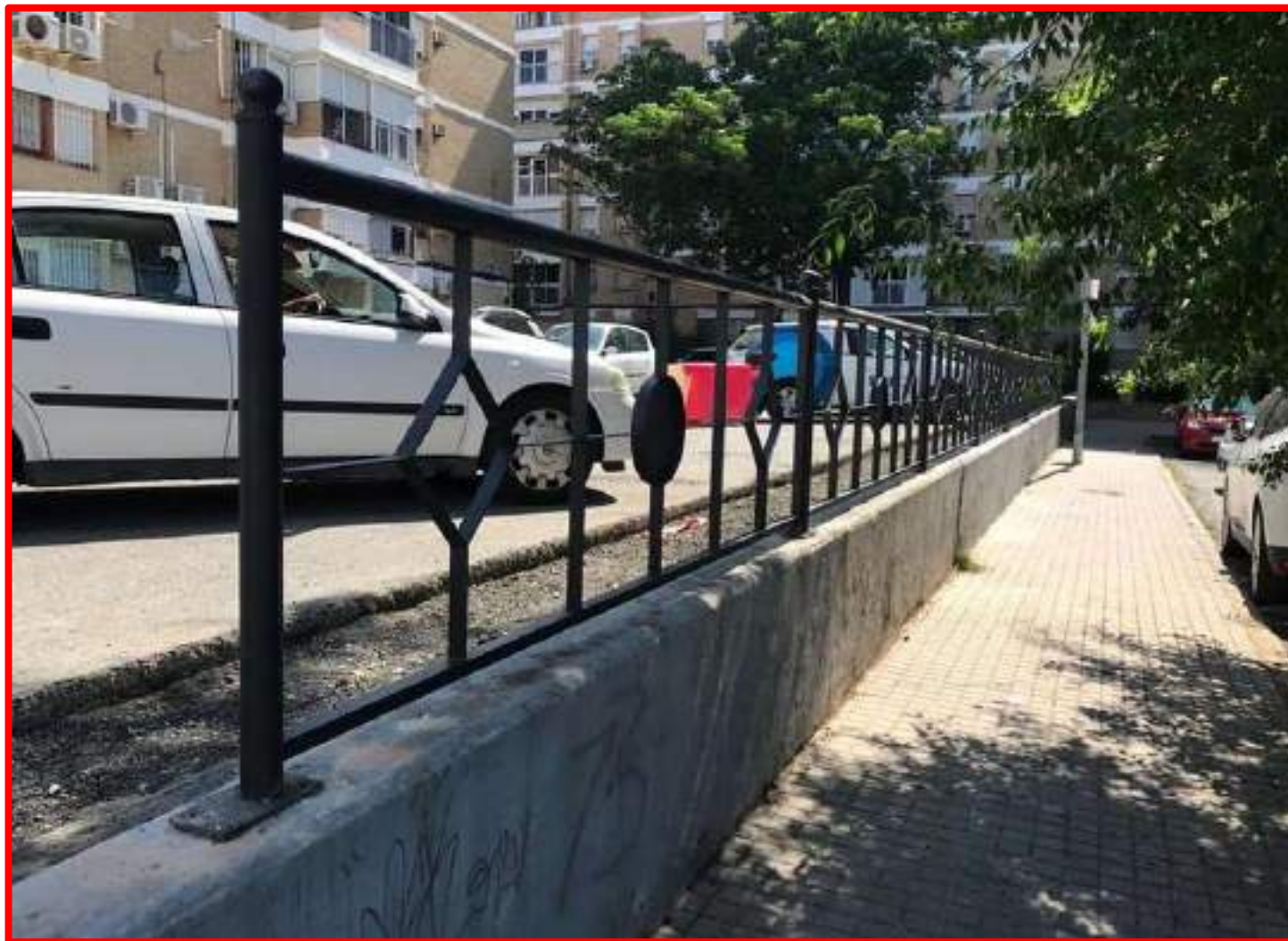
Instalación de vallado C/ Puerto de Viella
