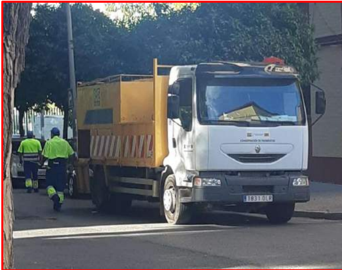
Reparación calzada C/ Navío Argos
