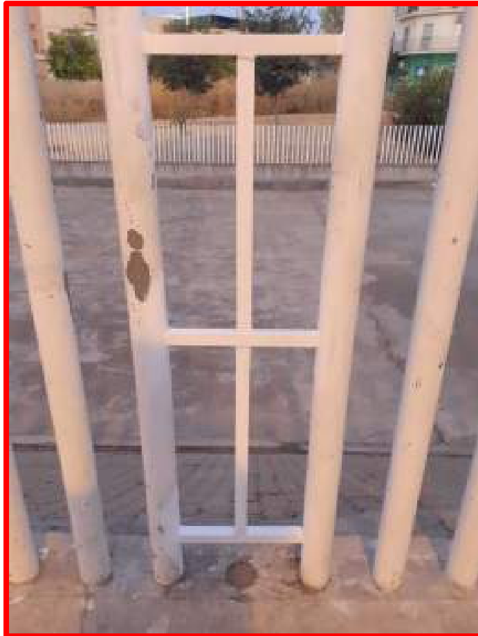
Arreglo varios tramos de vallado Canal Ranilla
