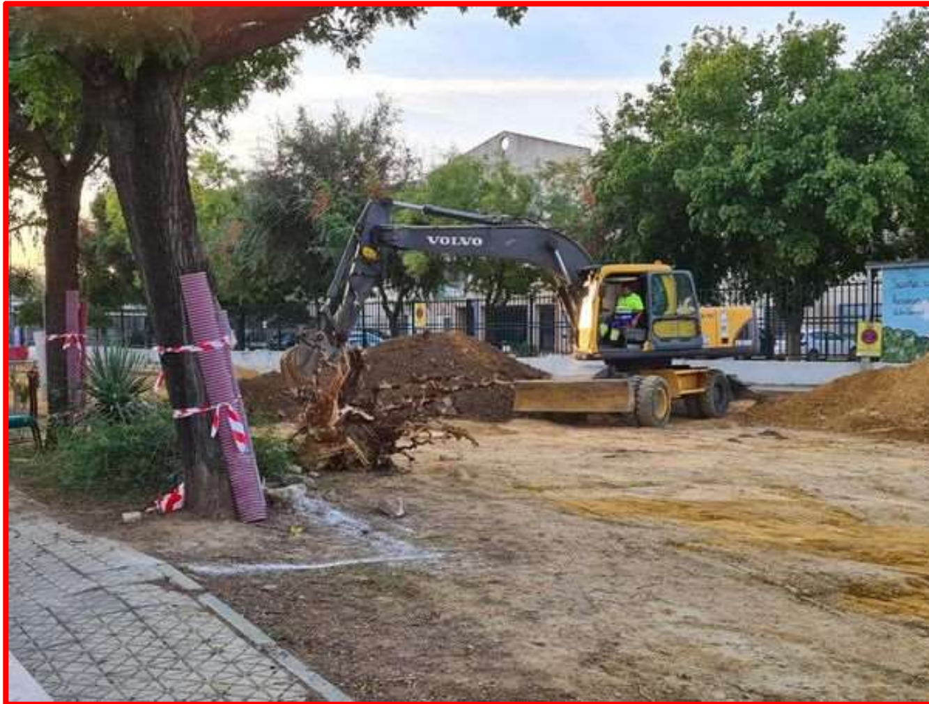
Ampliación de acerado C/ Bollullos
