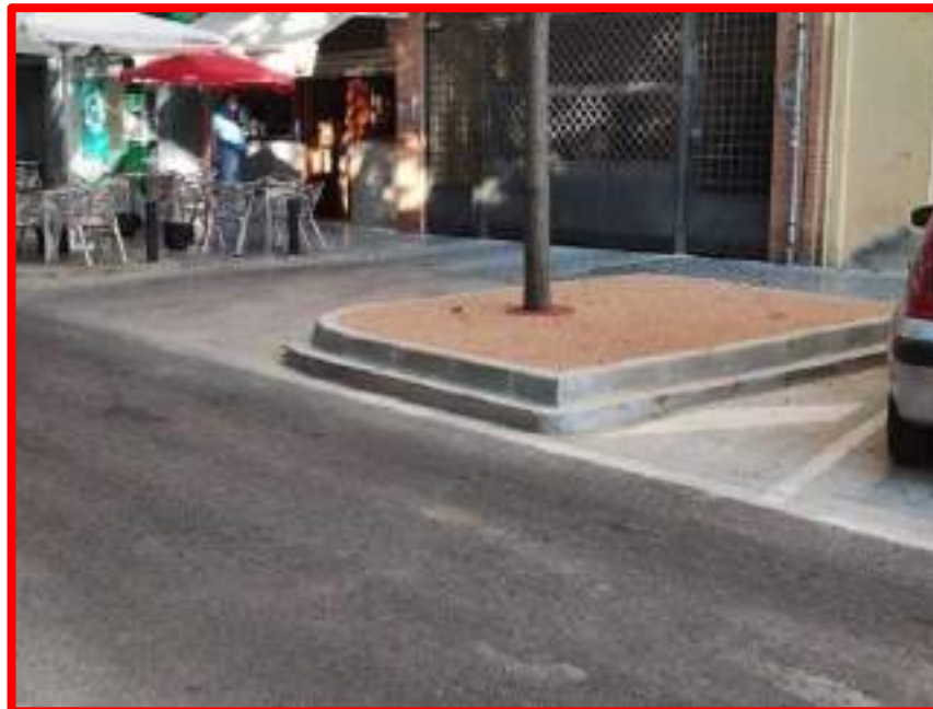
OBRAS ALCORQUES C/ JOSÉ MARÍA DE PEREDA
