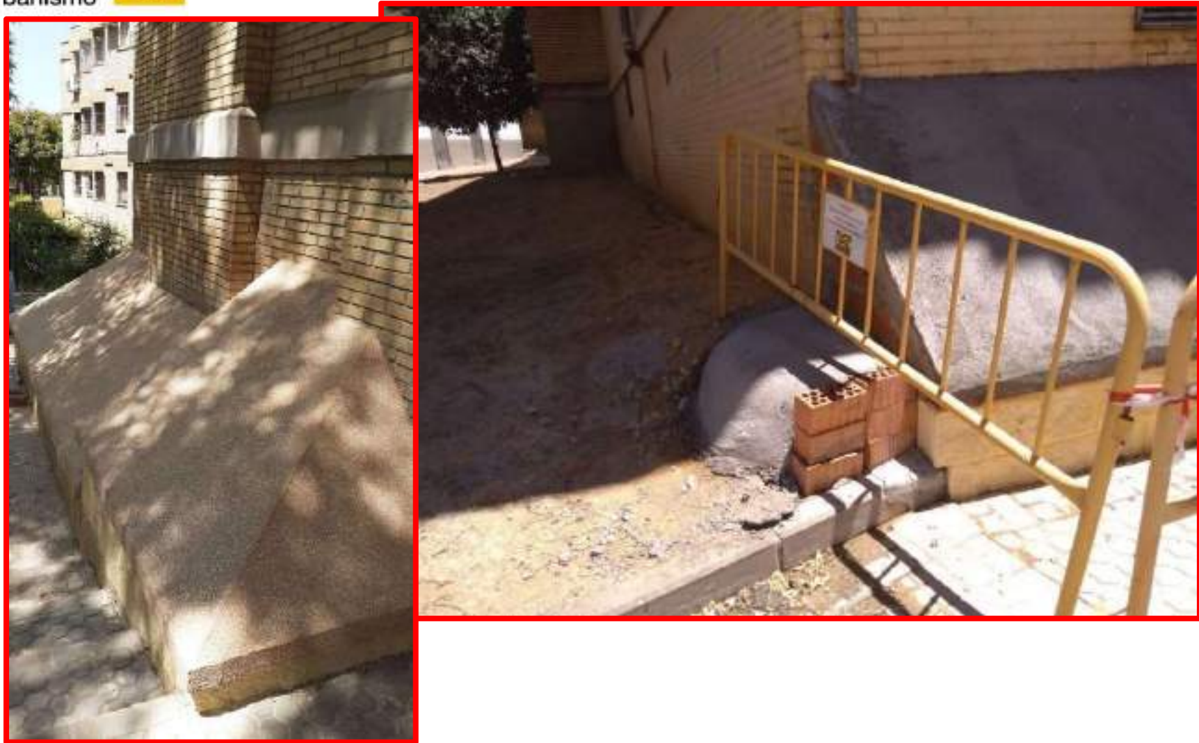
Arreglo fachada bloque C/ Juan Carvallo
