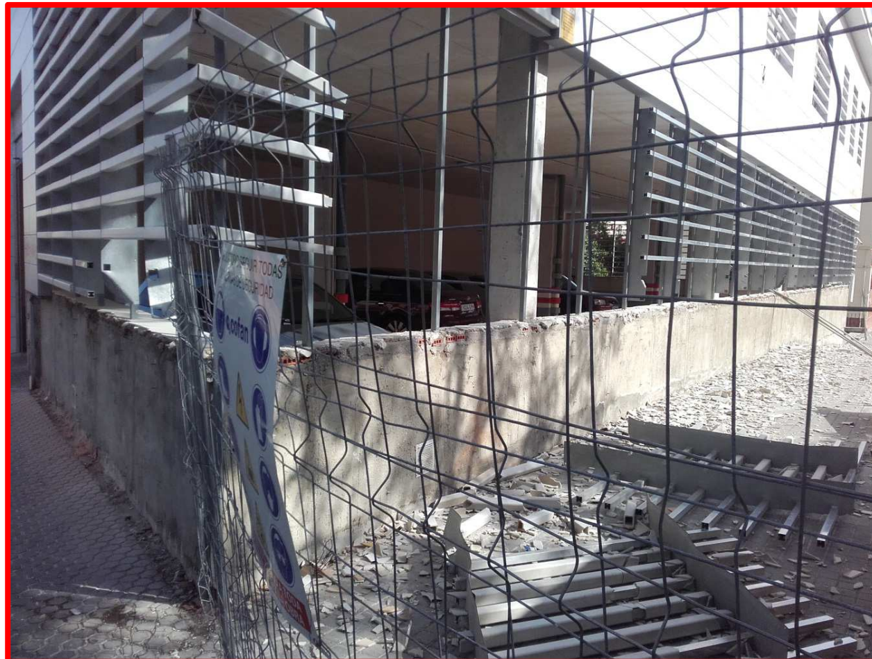
Mejoras en fachada edificio U.T.S. C/ Tarragona
