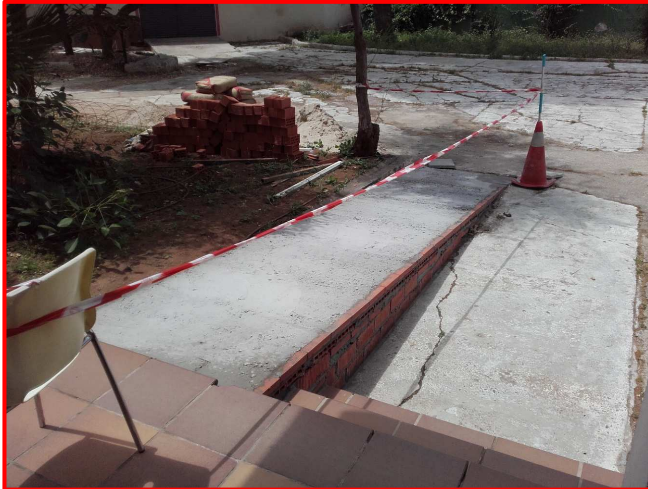
Obras de mejoras de accesibilidad en C.F. San Fernando
