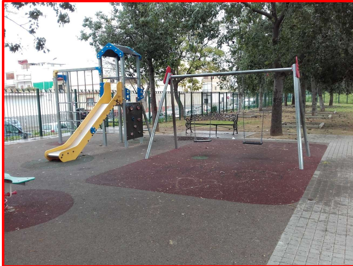
Reparación columpios parque infantil C/ Carmen Vendrell
